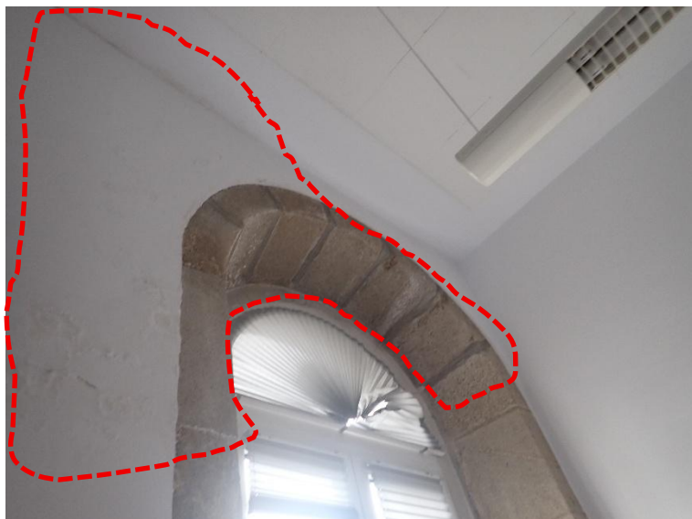
Fig.19. Imagen de la humedad existente en el paramento noroeste de la planta segunda (despacho). Zona oeste
