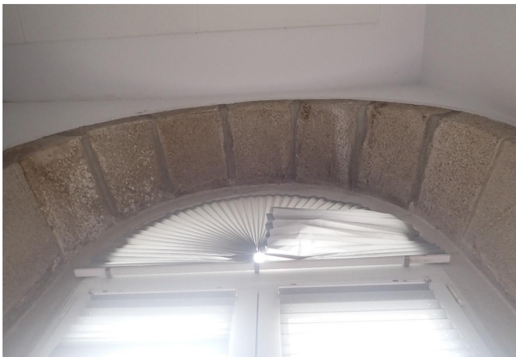
Fig.21. Detalle de las juntas de cantería del dintel de la ventana del despacho.
