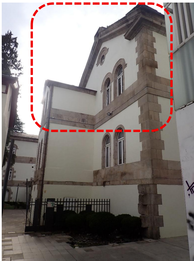
Fig.14. Vista del paramento noreste de la crujía norte desde la Calle Carril dos Romanos
