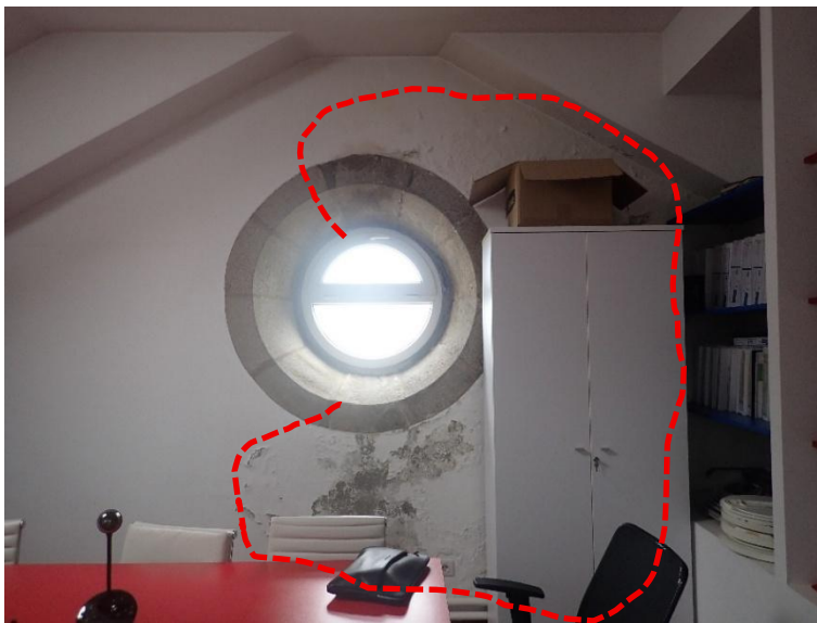
Fig.16. Imagen de la humedad existente en el paramento noroeste del bajo cubierta de la crujía norte (sala de reuniones). Zona central
