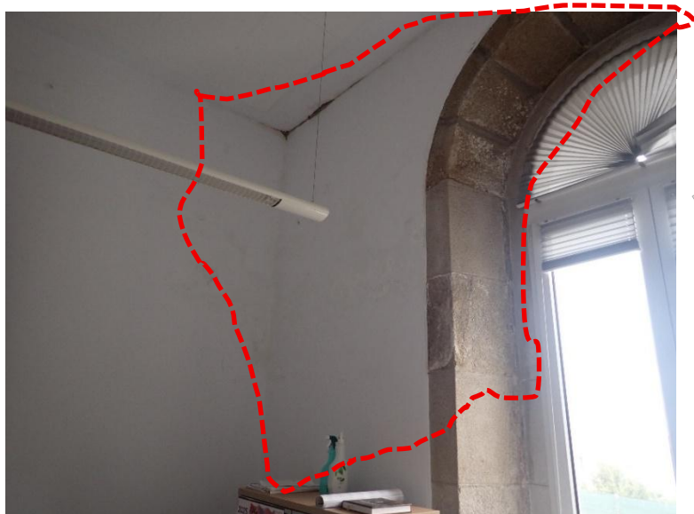
Fig.18. Imagen de la humedad existente en el paramento noroeste de la planta segunda (despacho). Zona oeste
