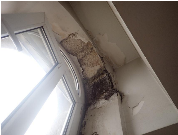
Fig.24. Efecto de la humedad en el arco interior de las ventanas de los baños del cuerpo adosado.
