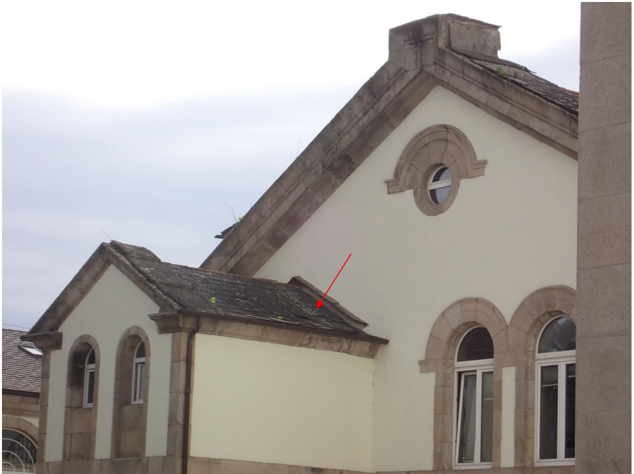
Fig.23. Vista de la cubierta de los aseos. No renovada en la intervención anterior.
